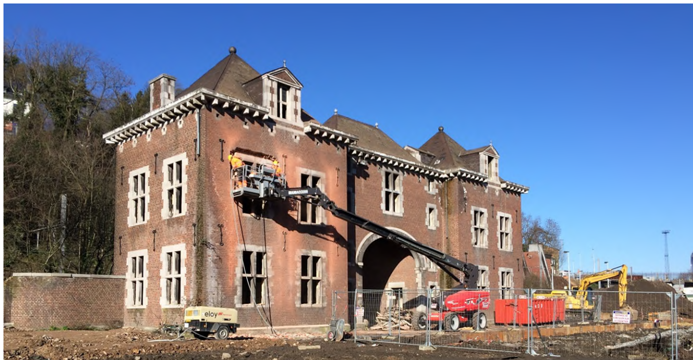
Figure 1- opération de déconstruction en 2017
