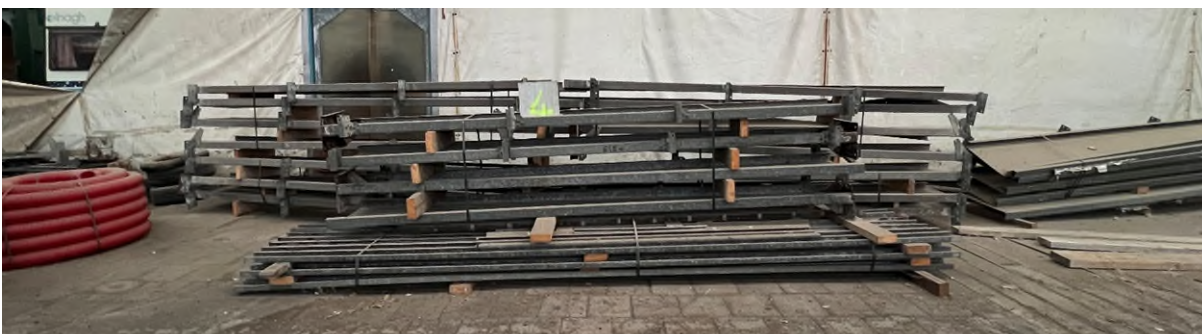
Hangar 4 : 7 fermes, 4 pieds-droits en tôle en pliée et les lisses
