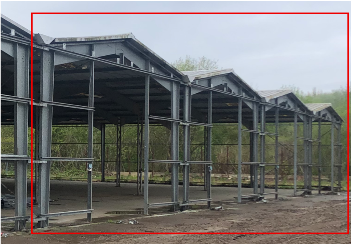
Photo 1 : En façade : 4 arches séparées en tôles galvanisées pliées
