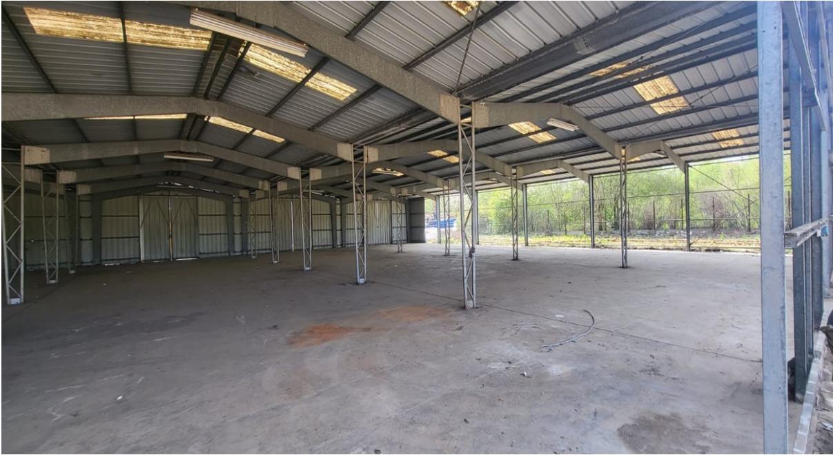
Photo 2 (vue intérieure des hangars sur 4-5-6) : Au centre, les pieds-droits en profil tubulaire.
